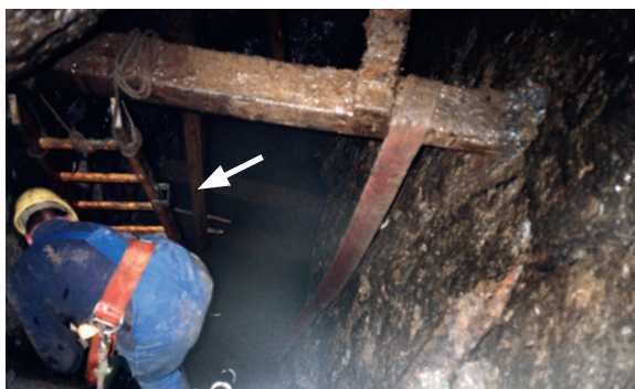
Abb. 8 Grube Gottesesegen, Bensbergs Gesenk. Blick in den Blindschacht mit Verzimмерung und Pumpengestänge (Pfeil) während der Befahrung 1976 (Foto: G. Schmidt).
