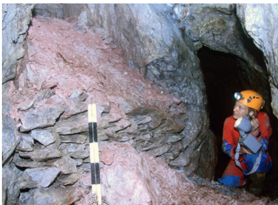
Abb. 15 Grube Gottessegen. Versatzmauer vor Querschlag 1 in der Nordstrecke (Foto: LWL-Archäologie für Westfalen/M. Zeiler).
