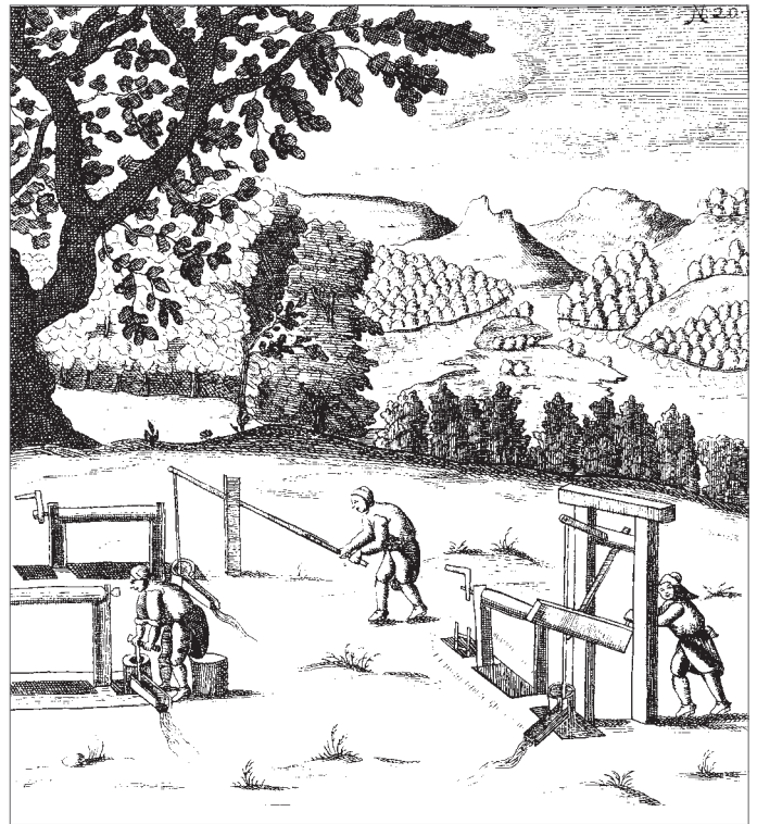
Abb. 12 Verschiedene frühneuzeitliche Wasserhebevorrichtungen (nach WINCKLER 1700, Abb. 2).
