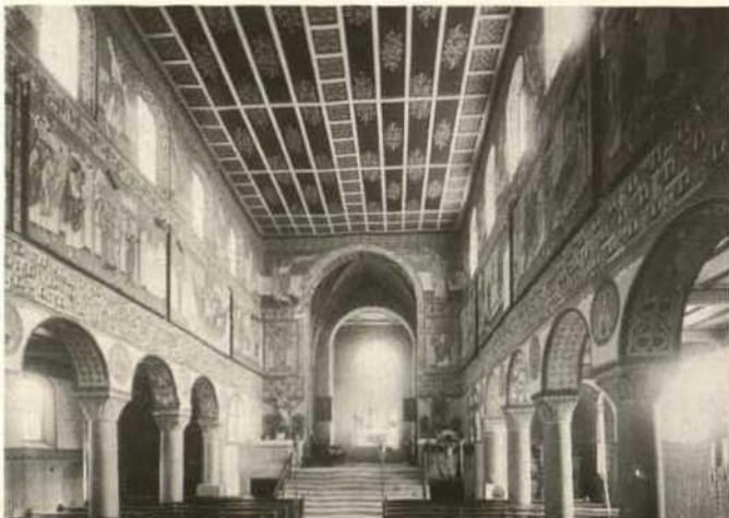
Abb. 48. Reichenau-Oberzell, St. Georg, Innenansicht nach Osten nach der Instandsetzung von 1890/92.
