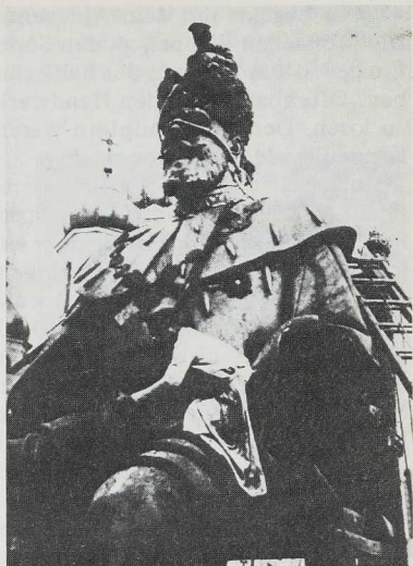
Abbildung 1 und 1a: Arbeiter befestigen die Seile zur Demontage des Denkmals
