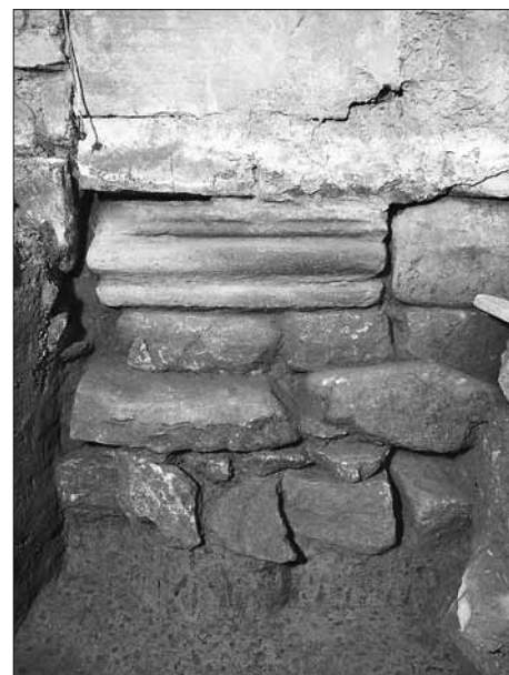
Abb. 1: Arnheider Kapelle (bei Breuberg-Rai-Breitenbach); römischer Gesimsblock unter der Nordwestecke.
