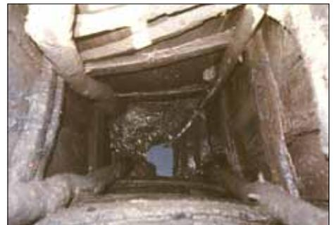
Abb. 3: Halle, Klausstraße, Blick in einen Kastenbrunnen mit Innengerüst und senkrecht eingeschobenen Spaltbohlen aus dem 12. Jahrhundert.
