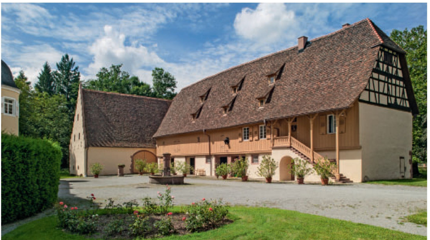
3 Blick auf die Scheune und die Meierei.
