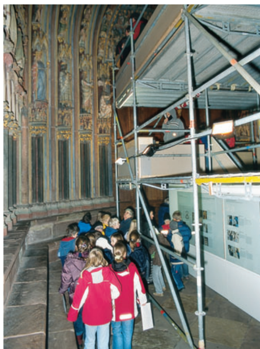
4–6 Blick in die Vorhalle während der Standzeit des Schaugerüstes.
