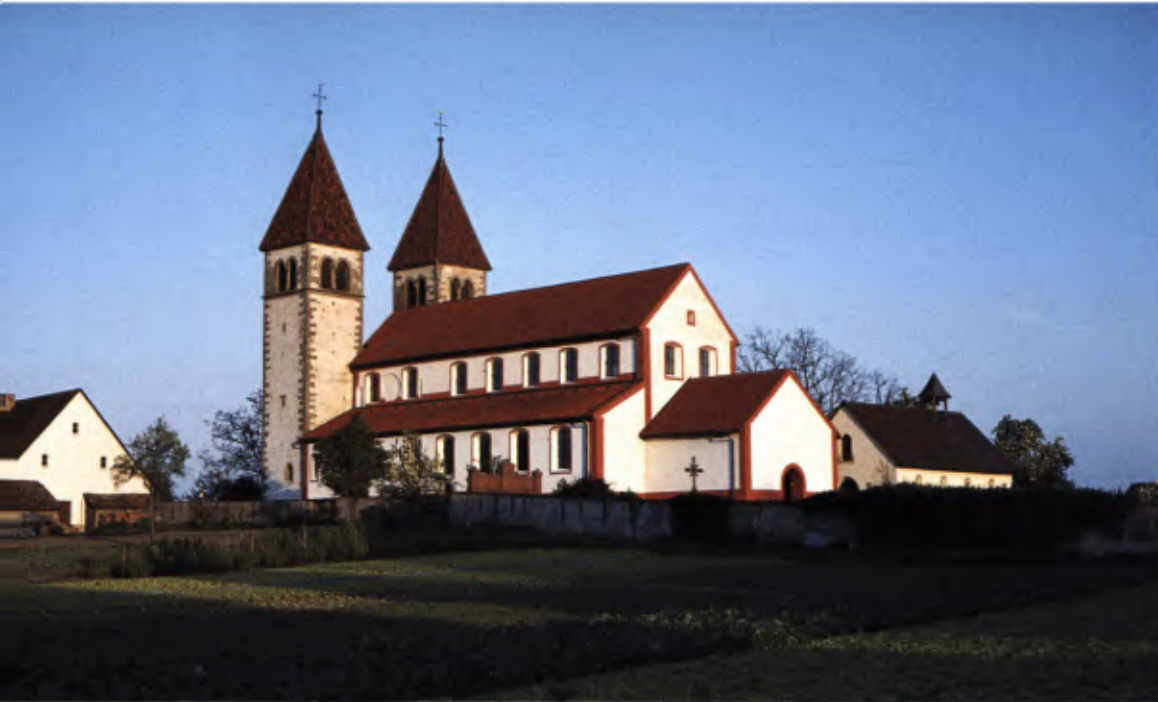
11 Niederzell, Stiftskirche St. Peter und Paul von Nordwesten, nach der Restaurierung 1970–1977.
