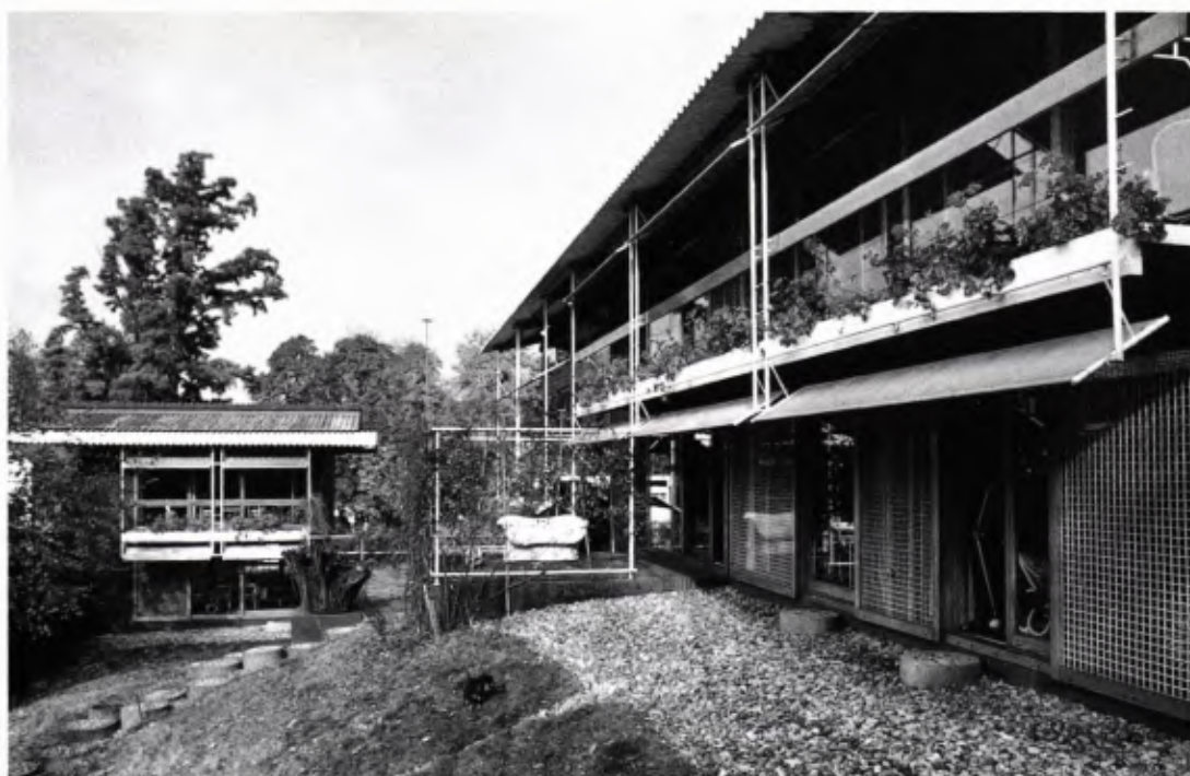
7 Baden-Baden, Villa Eiermann mit Atelierhaus, Gartenseite mit Terrasse, Kiesbett, Sonnensegeln und Gitterelementen.
