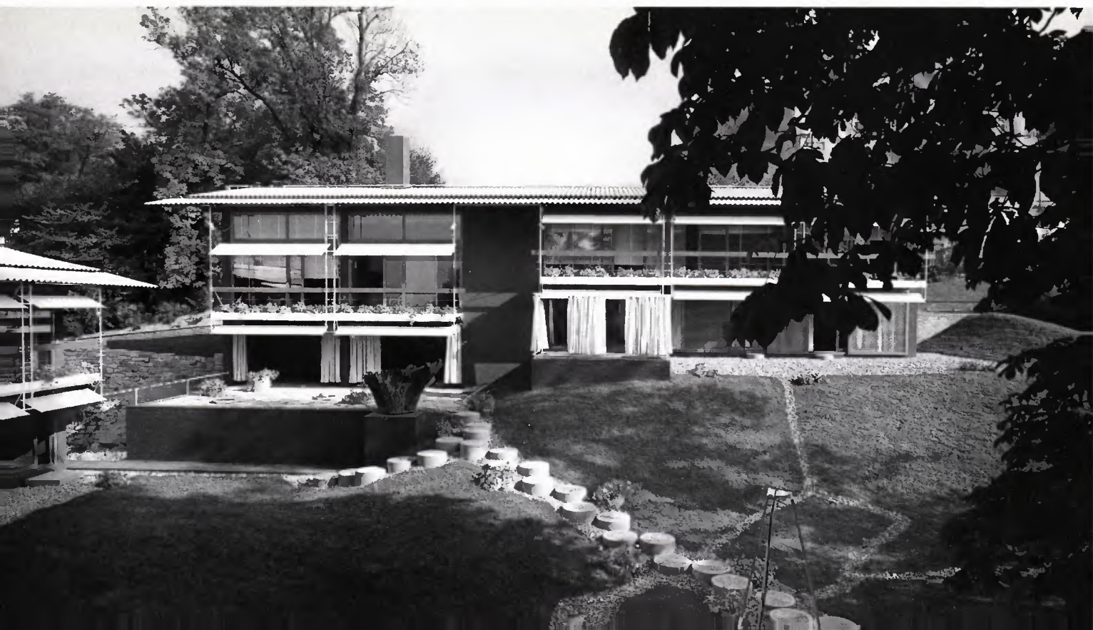
11 Garten der Villa Eiermann mit Wegen, Kiesbetten und Badebecken.
