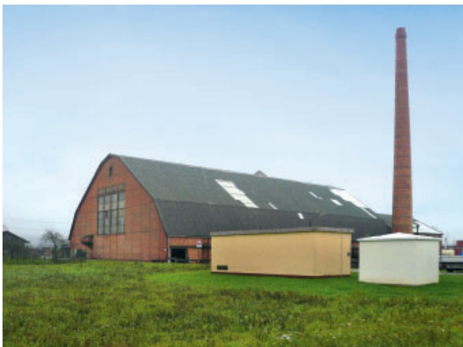
8 Sägehalle der Karl Richtberg KG in Auggen, November 2012.
