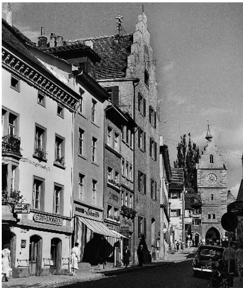
1 Überlingen, Bild der Franziskanerstraße nach Norden im Jahre 1957 mit dem hoch aufragenden Ostgiebel des Steinhauses und dem Franziskanertor im Hintergrund.
