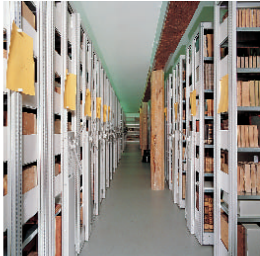
6 Erstes Obergeschoss. Zwischen den Deckenbalken sieht man die Stahlbeton-Rippen der neuen Decke, die den Raum von Außenwand zu Außenwand frei überspannt, um die Lasten der Kompaktanlage aufzunehmen. Die historische Holzkonstruktion blieb unbelastet erhalten. Zustand 1996.
