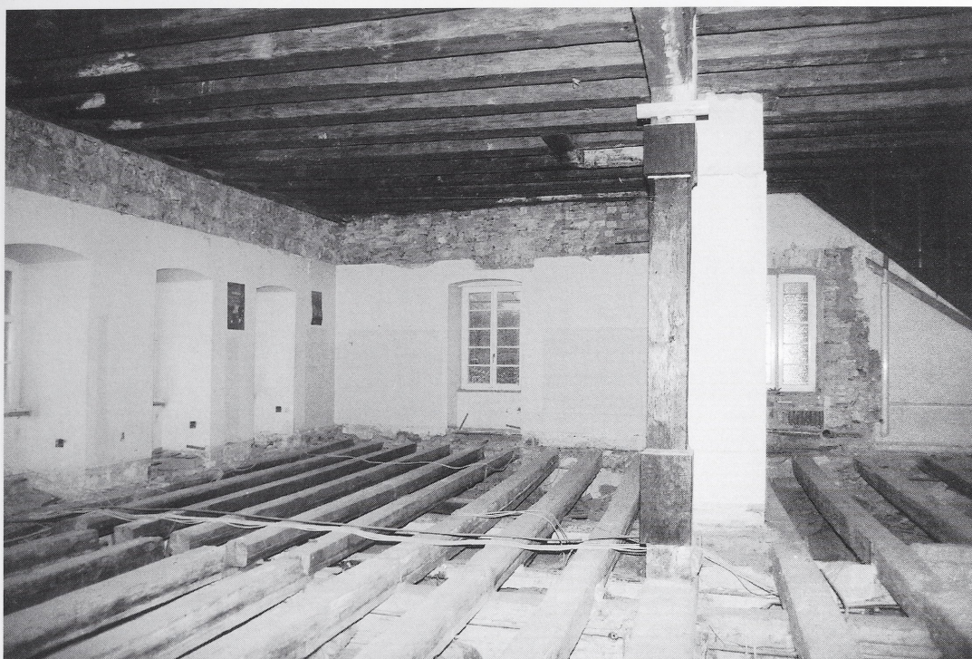
Abb. 27: Überlingen, Greth. Blick in die Südwestecke des Obergeschosses der westlichen Gebäudehälfte. Der Putzabsatz an den Wänden markiert die einstige Decke des barocken Wohnungseinbaues für den Grethmeister.
