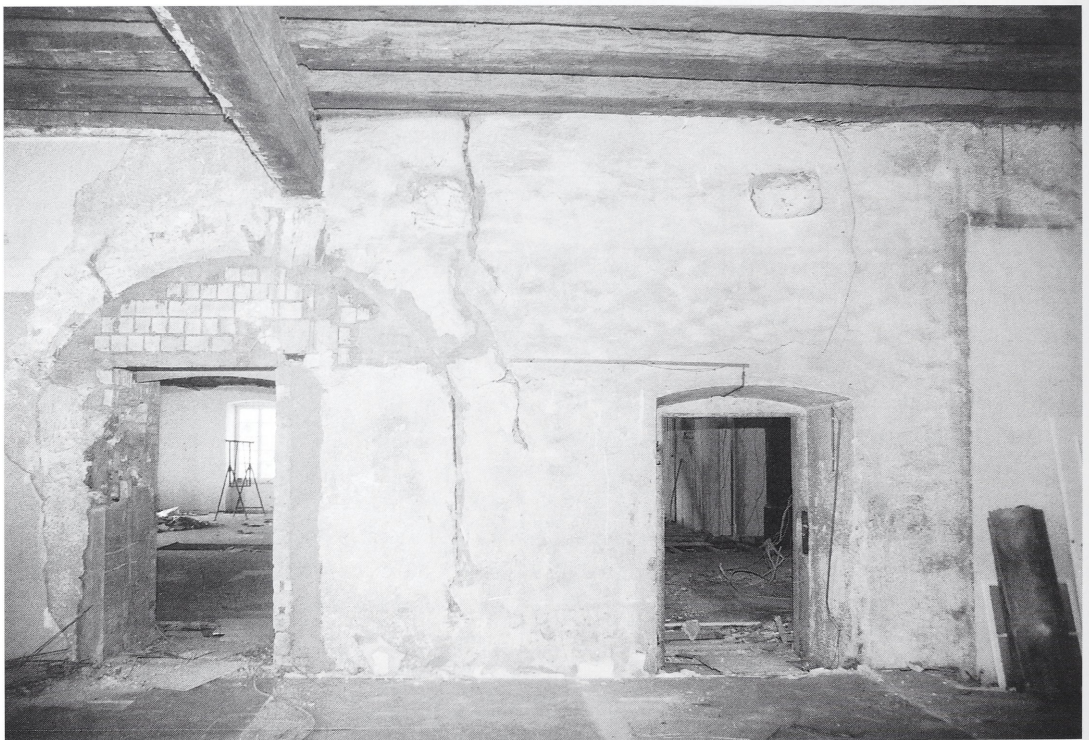
Abb. 26: Überlingen, Greth. Spätmittelalterlich/frühneuzeitliche Bogenöffnung und barocke Türöffnung in der Mittelwand des Obergeschosses vor der Freilegung der rahmenden Malereien. Die in Deckennähe befindlichen Konsolsteine entstammen dem mittelalterlichen Deckenbalkenaufleger.
