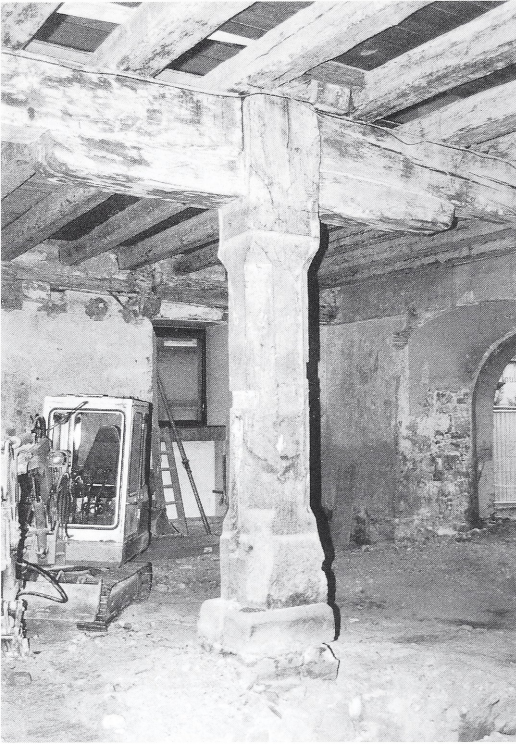
Abb. 21: Überlingen, Greth. Mittelalterlicher Ständer im Erdgeschoß der östlichen Gebäudehälfte.
