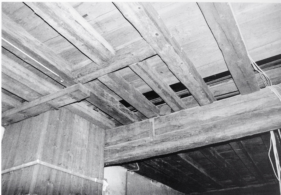
Abb. 29: Überlingen, Greth. Später verschlossene barocke Aufzugsöffnung im Dachgebälk über der westlichen Gebäudehälfte.
