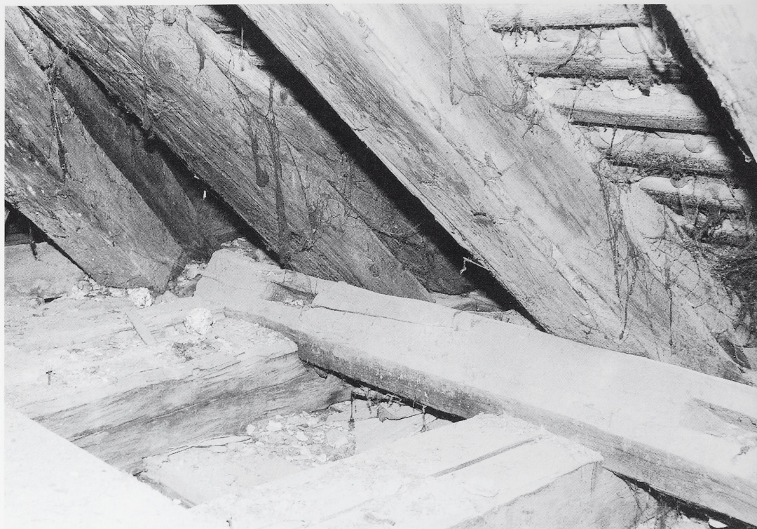
Abb. 31: Überlingen, Greth. Westliches Ende der nördlichen Stuhlschwelle des ersten Dachgeschosses mit Zapfenlöchern für eine ursprünglich im Zuge des geplanten Giebels vorgesehene, bei der Umänderung zum Walmdach aber nicht mehr ausgeführte Windaussteifung.
