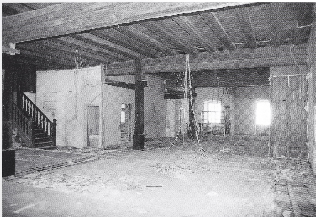
Abb. 28: Überlingen, Greth. Blick in den mittleren und nördlichen Abschnitt des Obergeschosses der westlichen Gebäudehälfte. Links die barocken Kammereinbauten und die Treppe zum Dachgeschoß.
