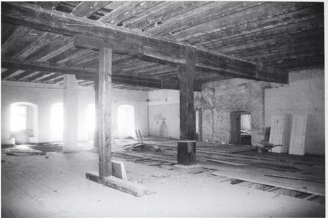
Abb. 25: Überlingen, Greth. Blick in die Obergeschoßhalle der östlichen Gebäudehälfte mit barockem Tragsystem und Deckengebälk.
