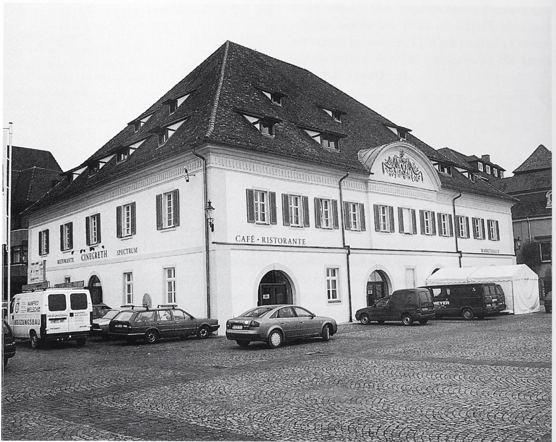
Abb. 1: Überlingen, Greth. Ansicht von der Südwesten (1998).
