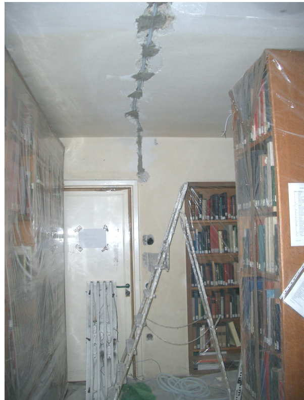
Mitten in der Renovierung
