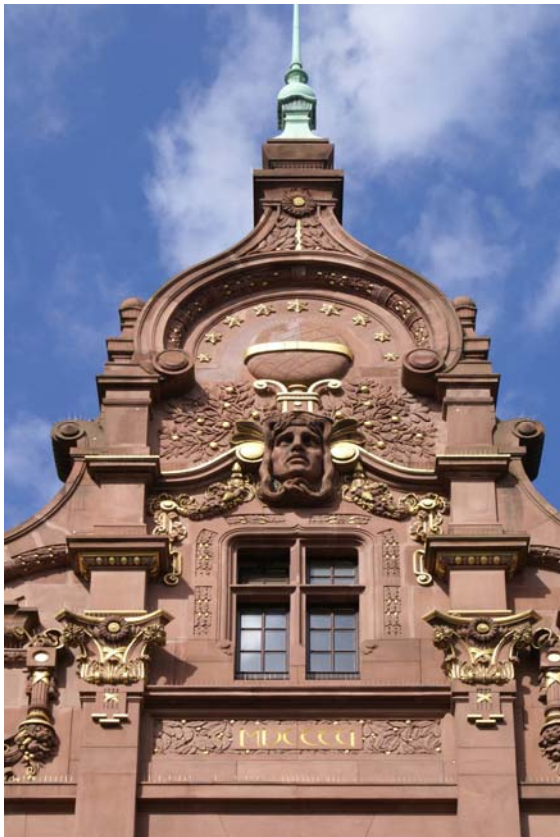
Abb.: Giebel der Südfassade des Altbaus von 1905
