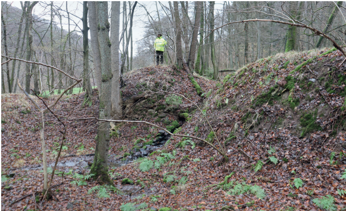
Abb. 6 Leicht erodiertes Ende eines Obergrabens für ein Wasserrad im Nahmertal bei Schalksmühle (Foto: LWL-Archäologie für Westfalen/D. Riemenschneider).
