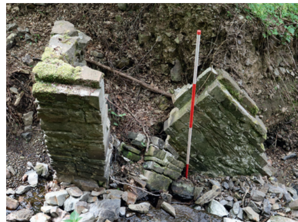
Abb. 9 Um- und unterspülte Reste eines Teils des rekonstruierten Pochwerkes in der Dahlenbecke bei Ennepetal (Foto: LWL-Archäologie für Westfalen/D. Riemenschneider).
