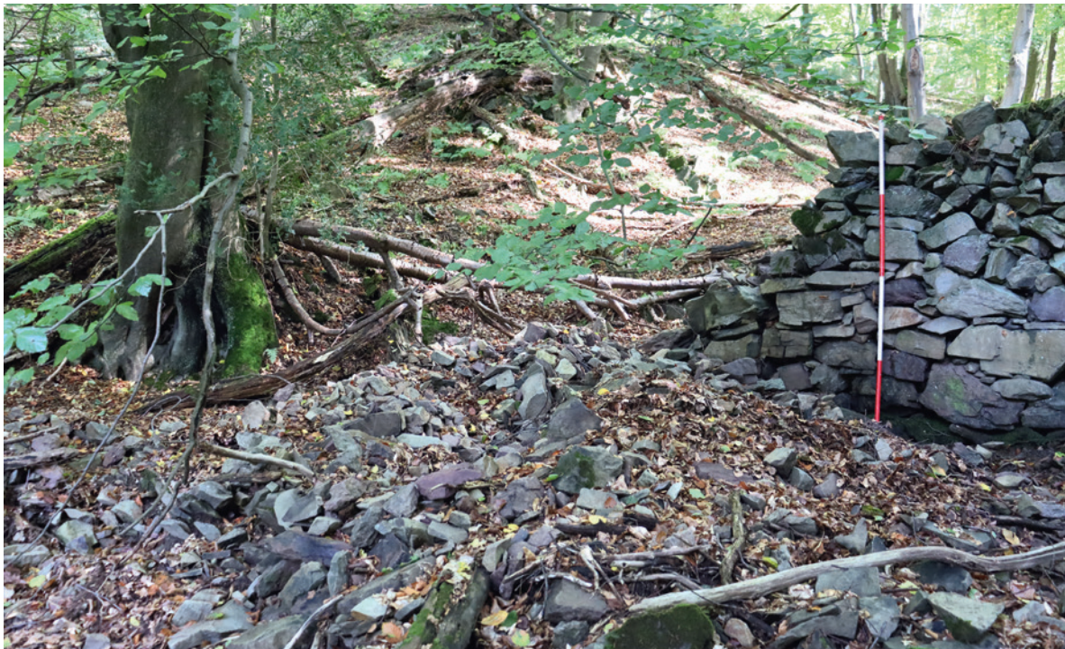
Abb. 10 Abgespülte Flanke des Trockenmauerwerkes am Arenseggebach in Hagen-Selbecke (Foto: LWL-Archäologie für Westfalen/D. Riemenschneider).
