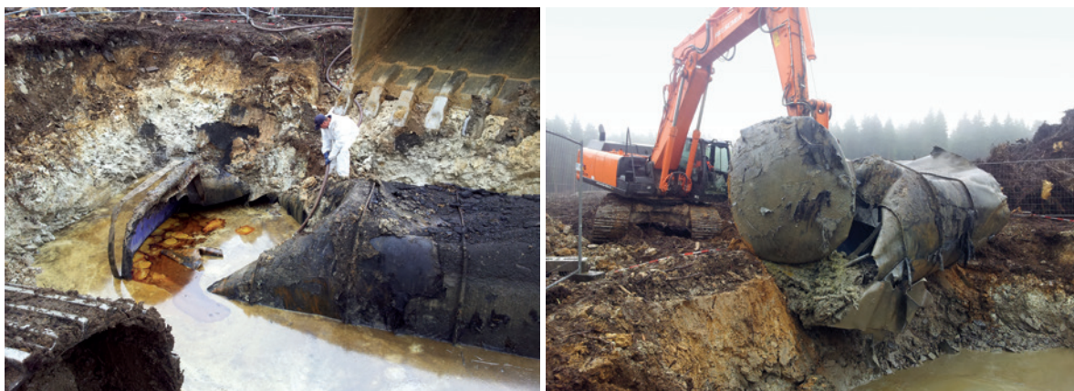
Abb. 33 Burbach, Kreis Siegen-Wittgenstein (AKZ 5214,197). Abpumpen von Treibstoffresten (links) sowie Bergung des Tanks (rechts) (Fotos: Gemeinde Burbach/A. Reitz).
