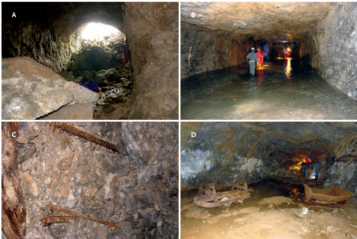
Abb. 21 Hemer-Deilinghofen bzw. Menden, Märkischer Kreis (AKZ 4512,20:AD01 und 205 sowie AKZ 4613,198). Untertägige Anlagen des Hydrierwerks »Schwalbe 1«. A: Mundloch; B: Strecke; C: Vortriebseinrichtung im Stoß; D: Strecke mit Fördereinrichtungen (Fotos: LWL-Archäologie für Westfalen/M. Baales).
