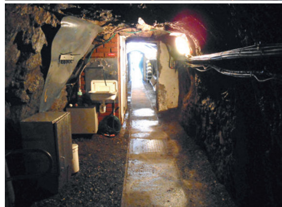
Abb. 5 Reinhold-Forster-Erbstollen, Siegen-Eiserfeld, Kreis Siegen-Wittgenstein (AKZ 5113,168). Portal (oben) sowie heute nahezu abgebauter und umgestalteter Bereich der Luftschutzeinrichtung (unten) (Fotos: LWL-Archäologie für Westfalen/H. Menne, M. Zeiler).
