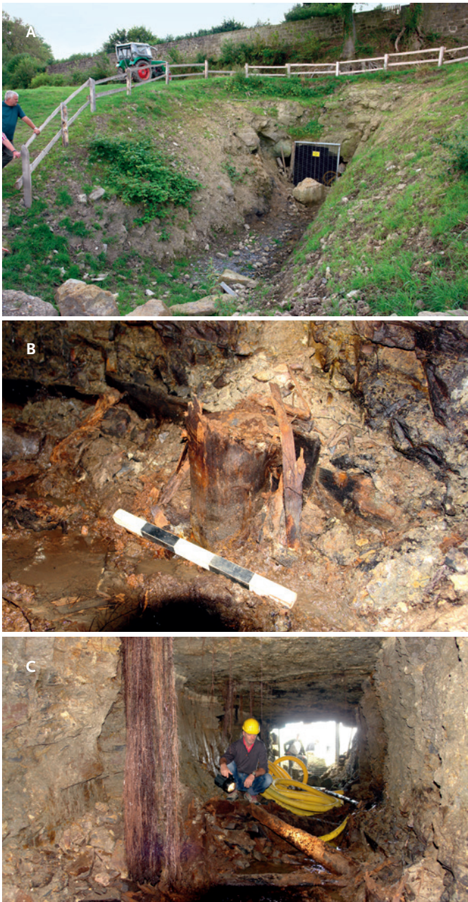
Abb. 14 Rüthen, Kreis Soest (AKZ 4516,152). Luftschutzstollen. A: Mundloch; B: Verzimmerungsreste am Stoß; C: Stollen (Fotos: LWL-Archäologie für Westfalen/M. Zeiler).
