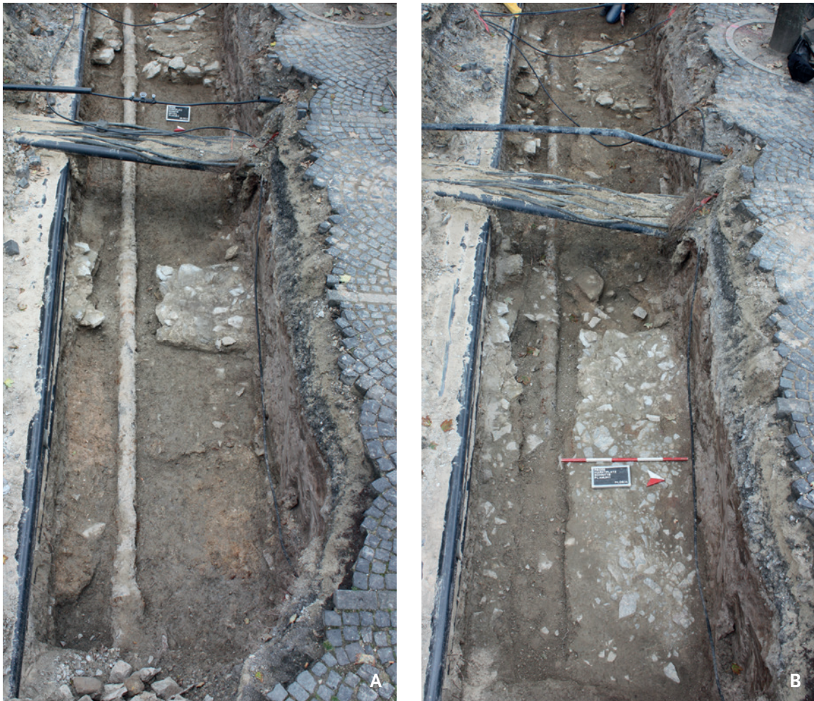
Abb. 23 Domplatz 2014 (Schnitt 6). A: Planum mit den beiden freigelegten, Nord-Süd-verlaufenden Mauerfundamenten; B: Planum mit Pflaster und den beiden darin einbezogenen Fundamenten. Das vordere Fundament ist im Pflaster nur anhand des Mörtels zwischen den Kalksteinen erkennbar (Foto: LWL-Archäologie für Westfalen/S. Spiong).
