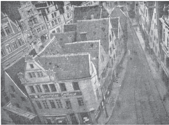
Abb. 29 Die Süd- bzw. Ostseite des Drubbels kurz vor dem Abbruch, um 1903. Blick vom Lamberti-Kirchturm (Foto: KLÖTZER 2008, 17).
