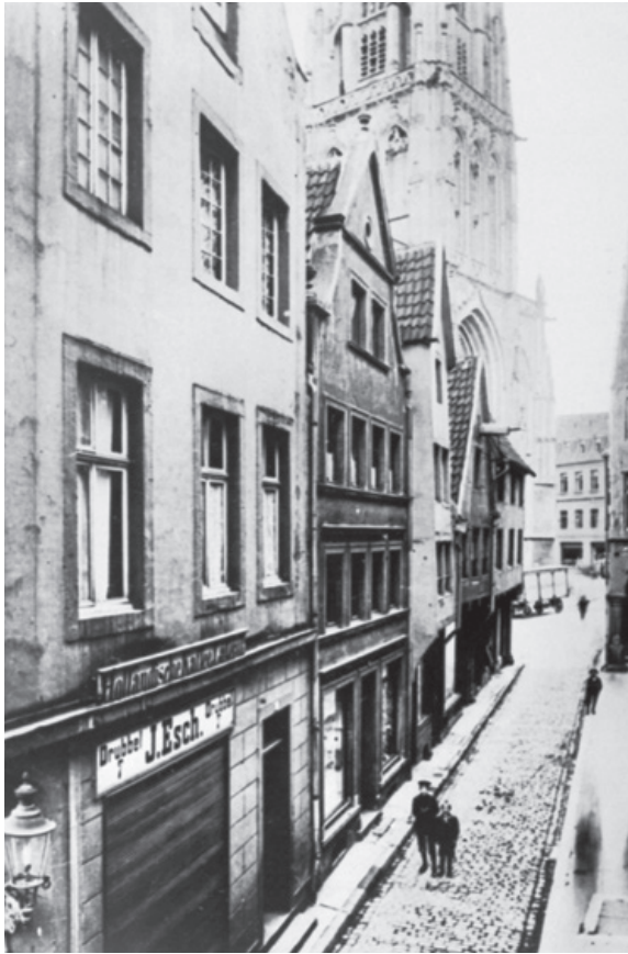
Abb. 37 Die Westseite des Drubbels kurz vor dem Abbruch, um 1903. Blick von Norden auf die Häuser Drubbel 7 bis 11 (von links) (Foto: LWL-Medienzentrum, Sammlung Julius Gaertner, Archivnummer 03_319).
