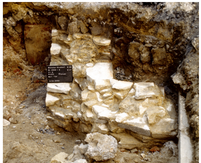
Abb. 12 Mauerecke des Bruchsteinfundamentes 734 in Haus Drubbel 12. Blick von Osten (Foto: Stadtarchäologie Münster).
