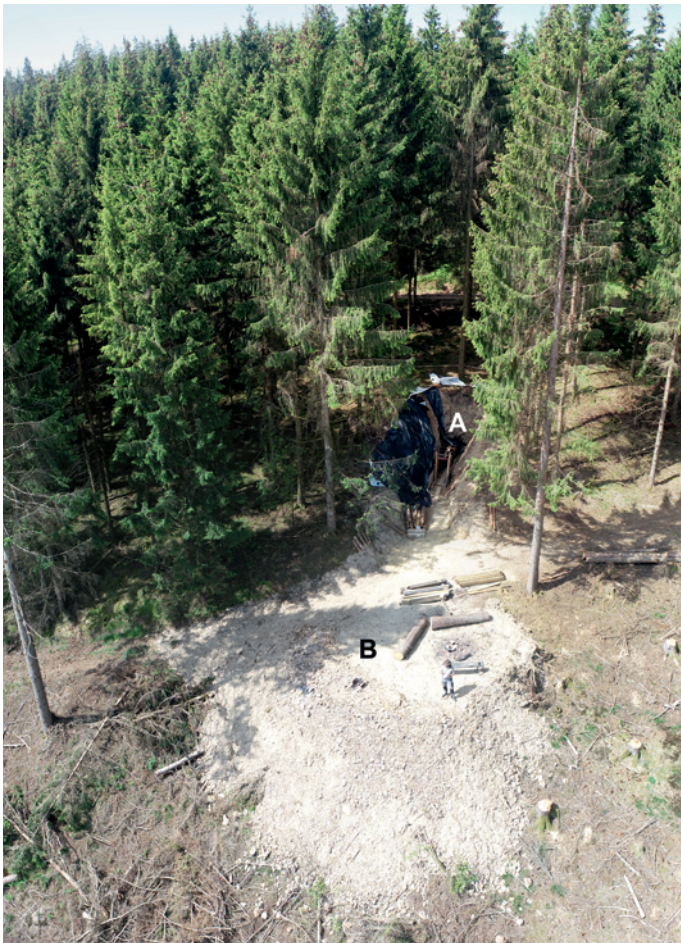
Abb. 9 Blick von Nordosten auf das frisch aufgewältigte Stollenmundloch (A) der Grube Wolf mit vorgelagerter Bergehalde (B) bei Hilchenbach-Müsen (Liste 2, 37) im Jahr 2021 (Foto: LWL-Archäologie für Westfalen/M. Zeiler. CC BY-SA).
