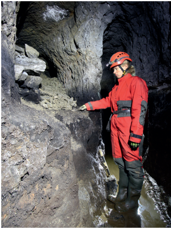
Abb. 13 Löhkopfstollen bei Wenden-Ottfingen (Liste 2, 24), Blick in den Stollen. Links mündet die niedrige Stollenstrecke bogenförmig ein, während bei der rechten Stollenstrecke die Sohle durch Schießen geweitet wurde. Die Hand der Archäologin gibt die Höhe der Sohle des älteren Stollens an (Foto: LWL-Archäologie für Westfalen/T. Poggel. CC BY-SA).
