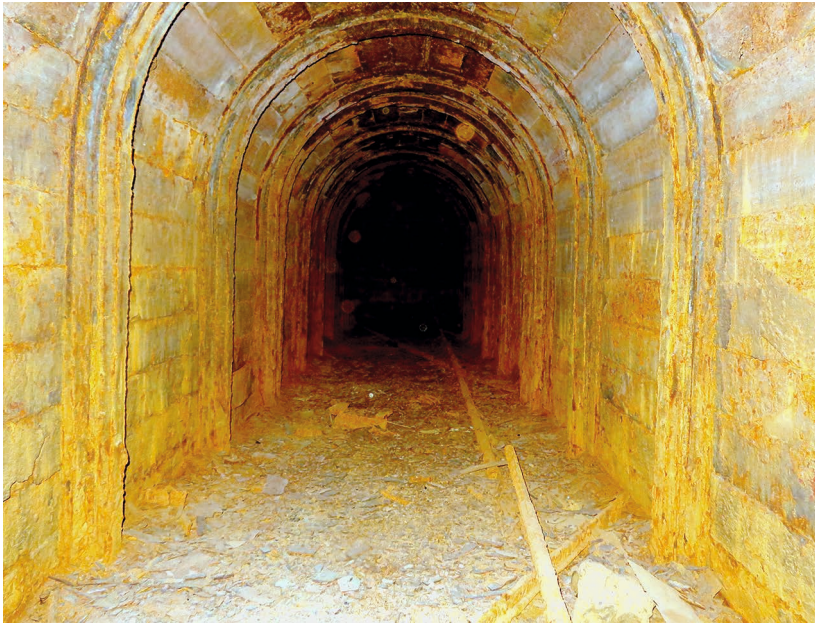
4 Essen-Bochold. Mithilfe von stählernen Dielen errichteter Schutzraum (Anlage 2).
