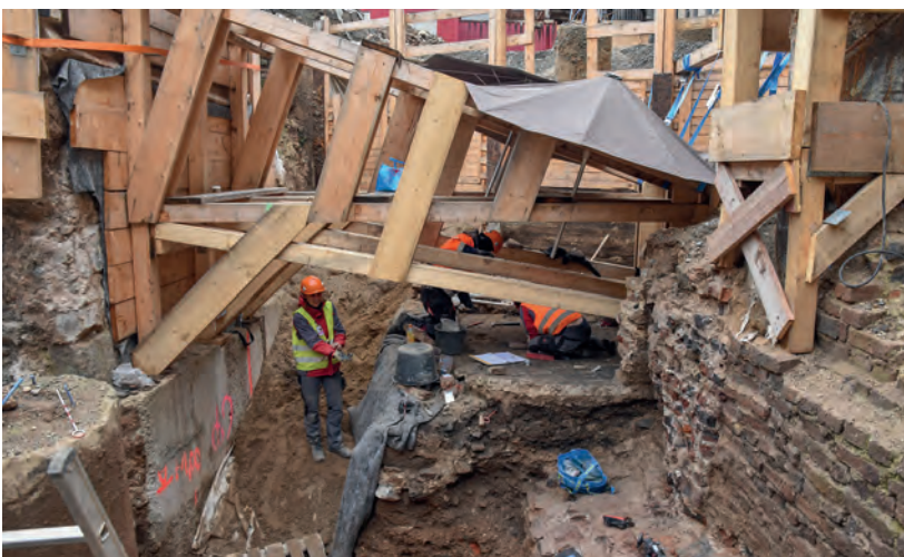
4 Köln-Altstadt-Nord, Archäologische Zone. Maßgefertigte Konstruktion zur Abstützung und Unterfangung einer Mauer mit hebräischer Inschrift.
