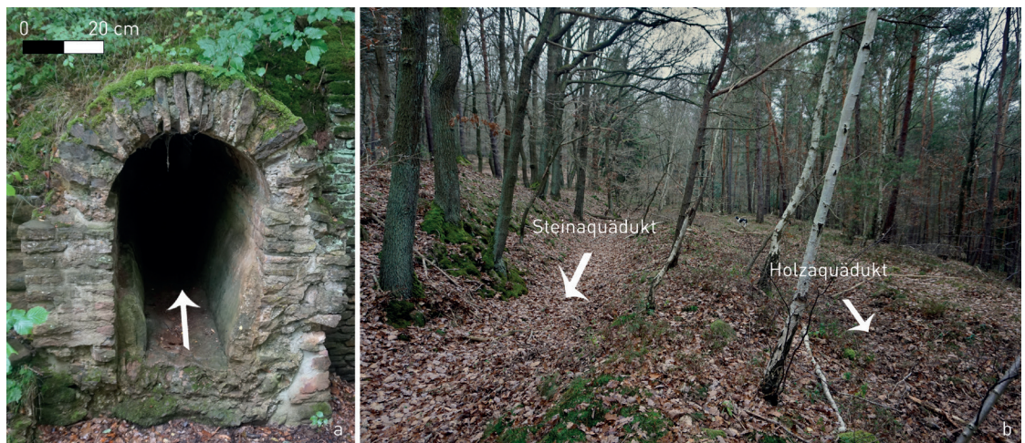
4 a Mechernich-Breitenbenden; b Mechernich-Kommern. Befundlage der römischen Eifelwasserleitung. Fließrichtungen durch Pfeile markiert. Lage siehe Abb. 3. a Querschnitt des in situ vorliegenden Aquäduktes bei Breitenbenden; b Morphologie im Wald zeigt doppelten Leitungsverlauf als Ausbruchgräben.
