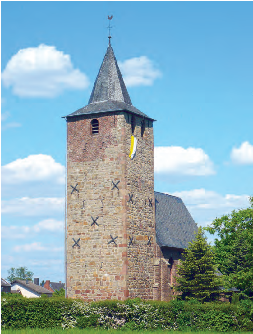
2 Düren-Distelrath. Das Mauerwerk des Turms der Distelrather Kapelle („Ühledömche“) weist deutliche Reparaturspuren nach Erdbebenschäden auf.
