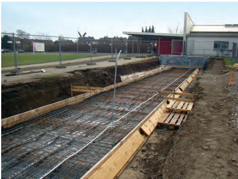
3 Xanten, LVR-APX. Betonfundament über dem Grabungsbefund.
