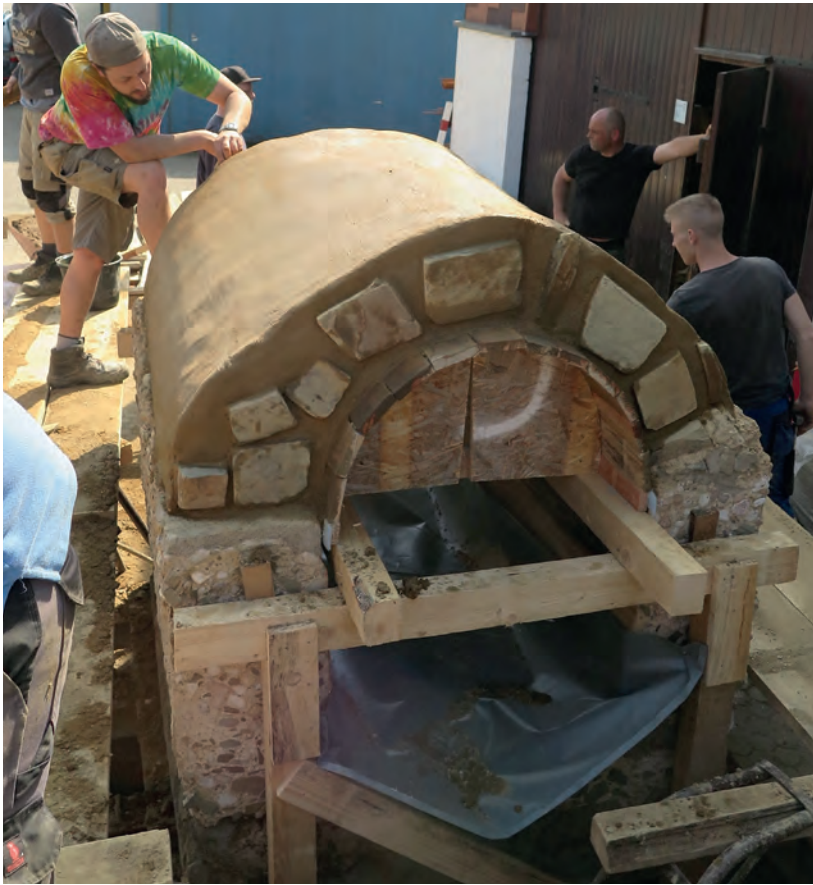
2 Köln-Ossendorf, Butzweiler Hof. Auszubildende der Handwerkskammer zu Köln beim Restaurieren eines Römerkanalsegmentes.
