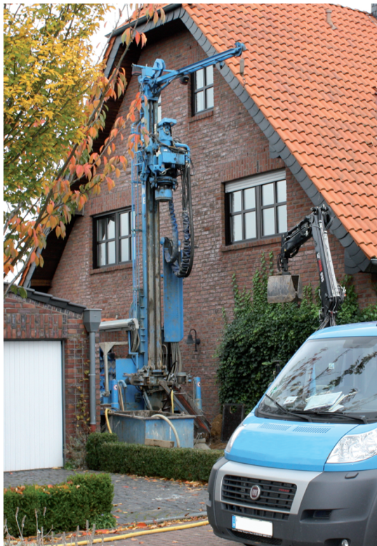
3 Typische Geothermiebohrung in der Niederrheinischen Bucht. Häufig ist die Bohrstelle durch vorhandene Bebauung beengt. Das Bohrgut wird in einem Container gesammelt.
