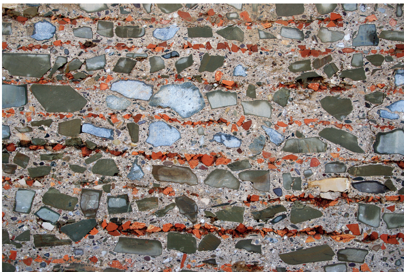
3 Köln. Gussmauerkern der südlichen Begrenzungsmauer des Zentralheiligtums.
