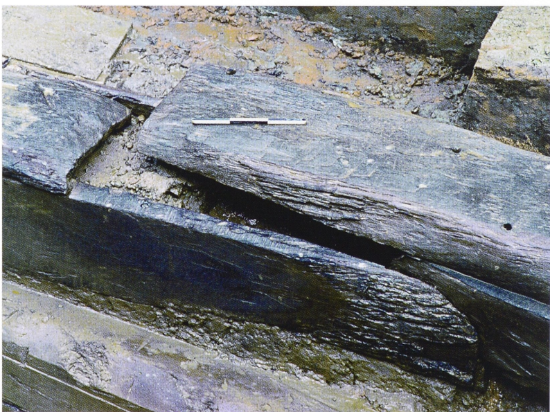
133 Blankenheim. Blick auf die obere Leitung mit Muffenverbindung.
