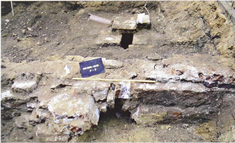
147 Jülich, Zitadelle. Fundamentmauer der Hauptwache mit Kanaldurchlass und Schacht.
