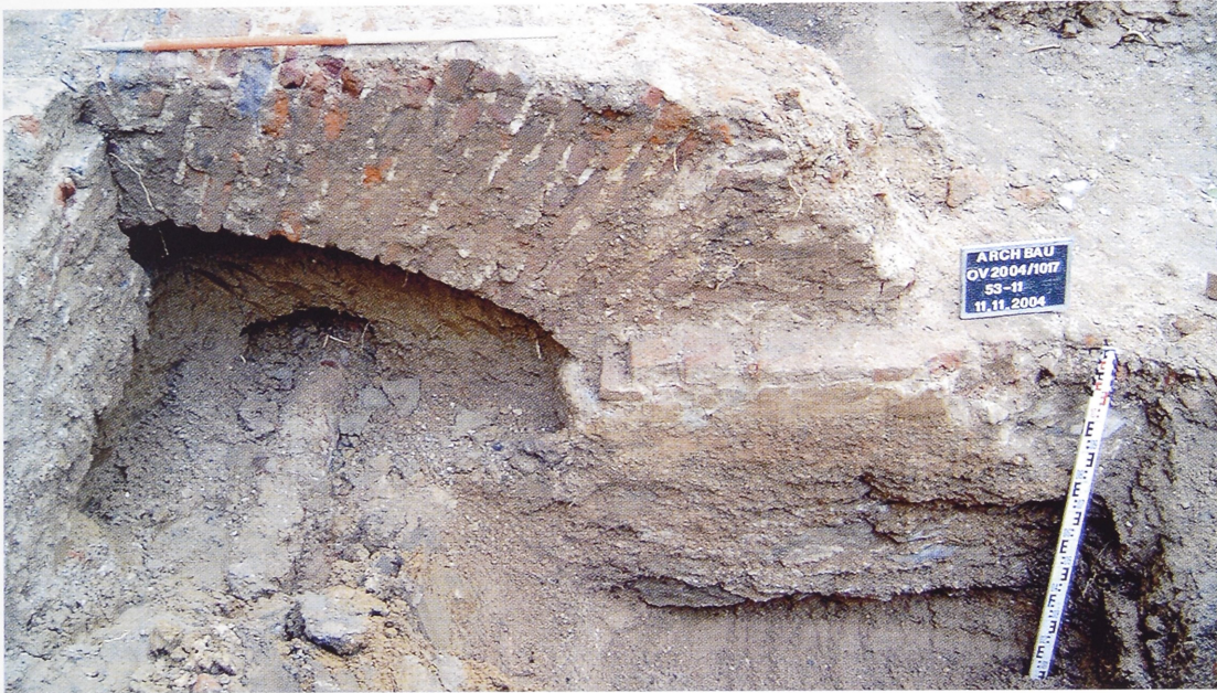
152 Düsseldorf, St. Andreas. Bogen mit Punktfundament.
