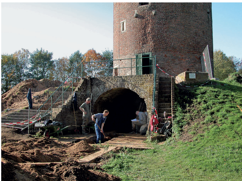
202 Krefeld-Oppum, Geismühle. Blick auf die Einfahrt aus dem 19. Jahrhundert. Sichtbar sind ein altes Turmfenster und die Konsolsteine des alten, hochliegenden Zuganges.
