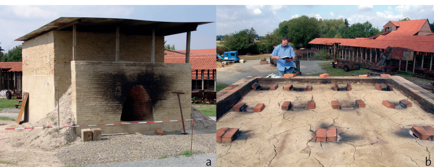
3 Lage (Westfalen), Ziegleimuseum. Nachbau eines Ziegelofens nach einem Ofenbefund in Dormagen. a Ofennachbau mit provisorischem Schutzdach nach dem Temporn am 5.8.2009; b Blick auf die Ofendecke mit den z. T. geöffneten Rauchgasöffnungen am 18.8.2009.
