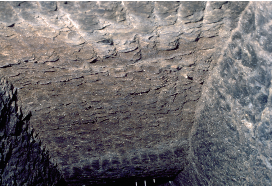
3 Lohmar-Deesem. Stollen mit Schlägel-Eisensetzung aus dem späten 16./frühen 17. Jahrhundert.
