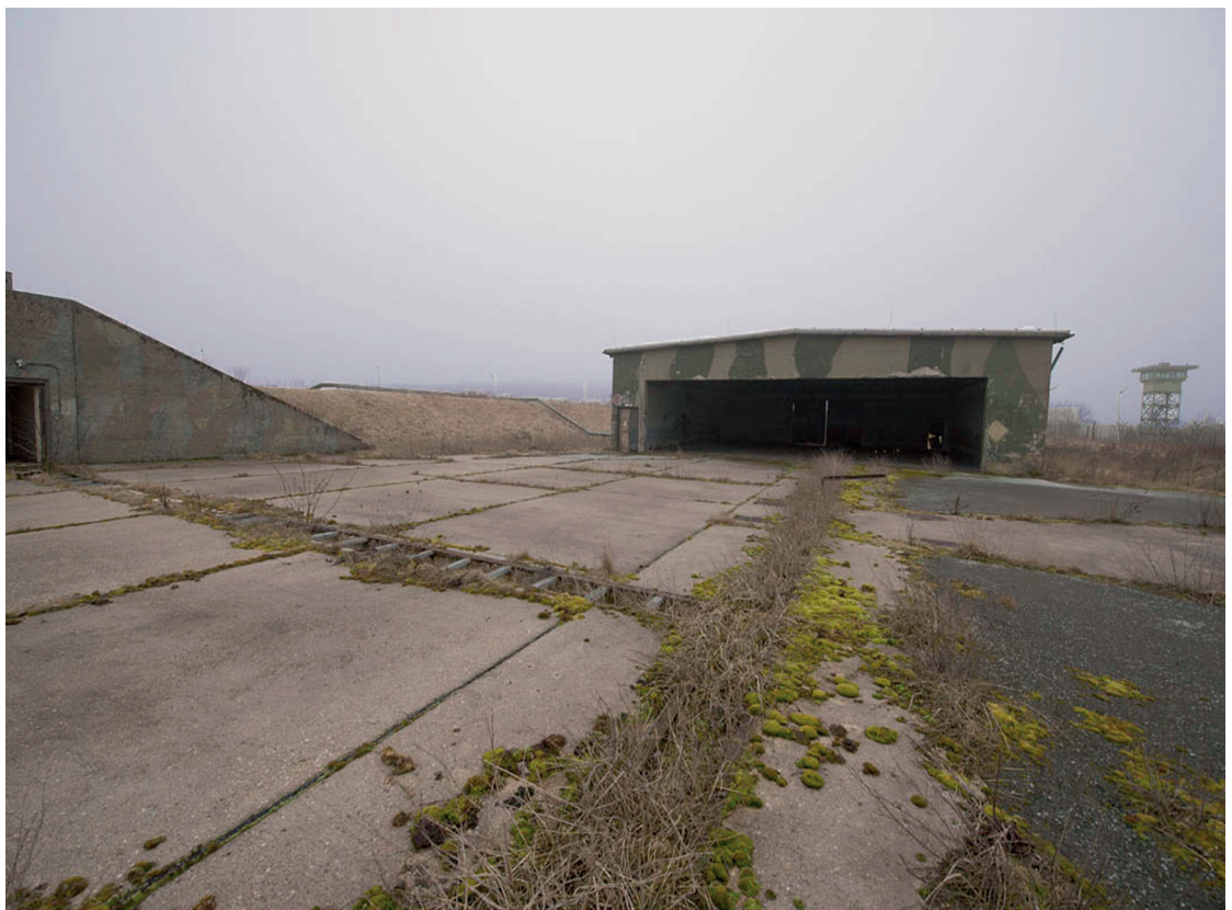
2 Blankenheim. Ehemalige Nike-Flugabwehrraketenstation, Abschussbereich; Shelter zur Lagerung der Raketen, im Vordergrund aus dem Shelter führend die Relikte der Laufkatze mit der die Raketen aus der Lagerhalle transportiert und zum Abschuss aufgerichtet wurden. Im Hintergrund Wachturm, Splitterschutzwälle und Mannschaftsbunker.
