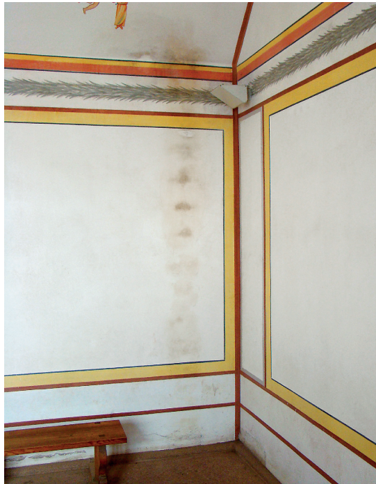
102 Xanten, CUT. Versottungsflecken im Trepidarium.
