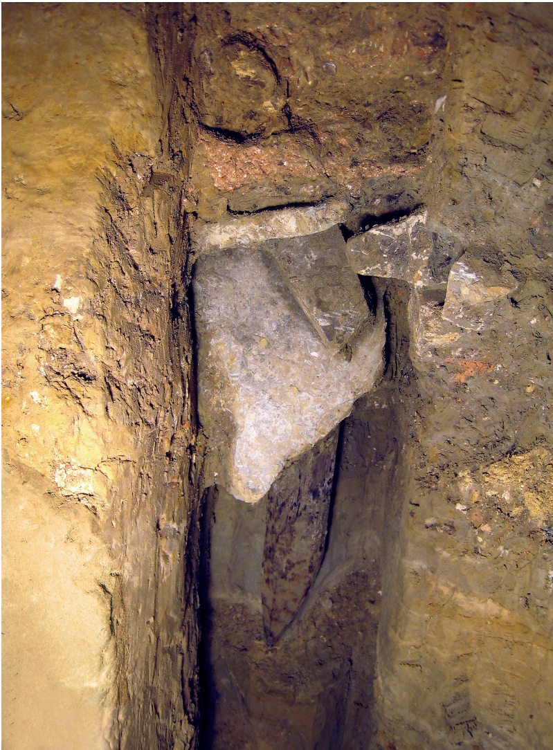
158 Aachen, Dom. Eichenpfahl unter dem östlichen Oktogonpfeiler des Nordjochs.
