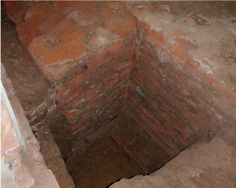
187 Düsseldorf, Schloss Eller. Spätmittelalterliche Burgmauern aus Backstein mit Stoßfuge.
