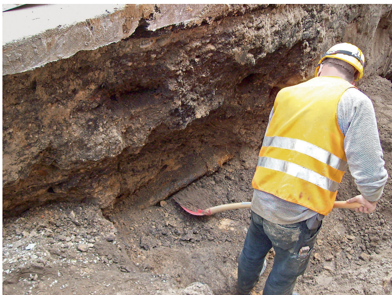
210 Essen. Teilweise freigelegte gusseiserne Rohrleitung, wohl vom Ende des 19. Jahrhunderts.
