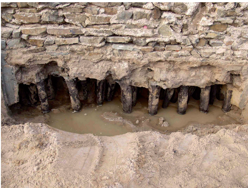
47 Xanten, CUT. Pfahlrost unter den Fundamentmauern der basilica thermarum .
