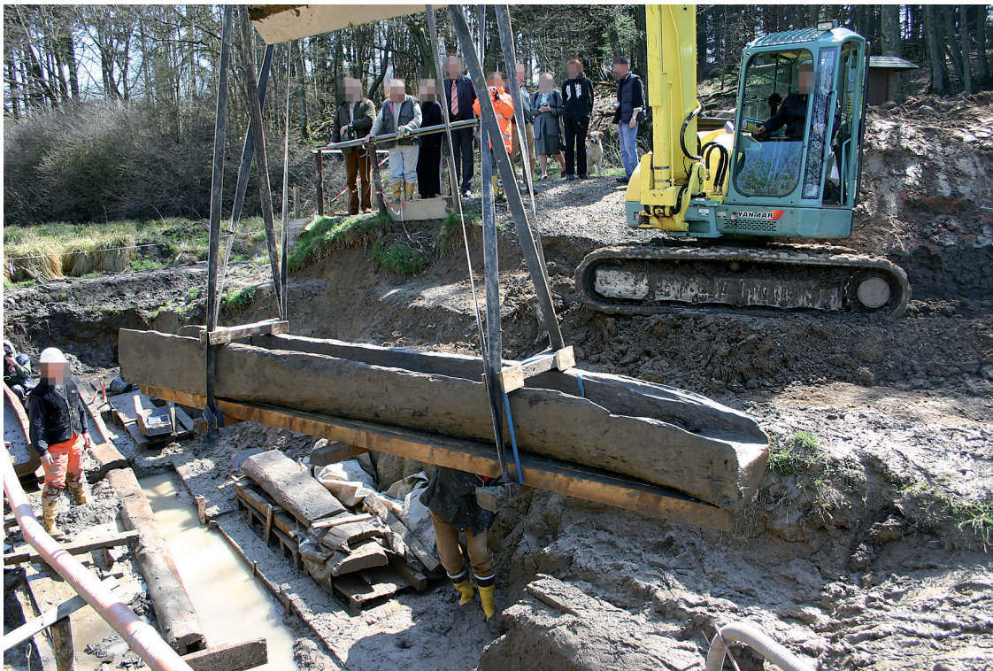
171 Blankenheim. Bergung der Holzrohre aus dem Damm des Deichelweihers.
