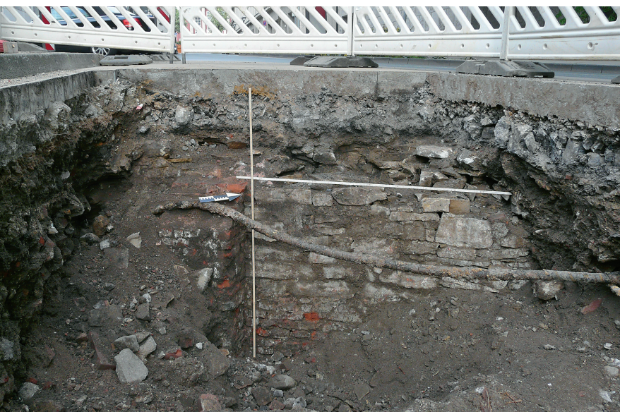
2 Essen. Der Mauerbefund im Kanalgraben von Osten mit neuzeitlichem Stützpfeiler und Backsteinunterfangung.
