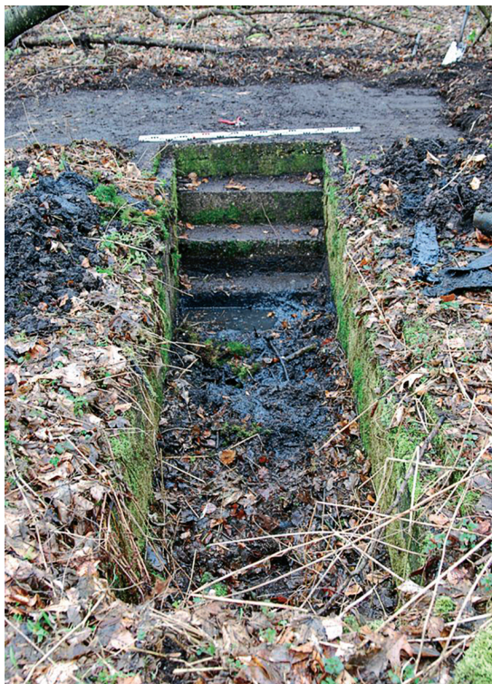
2 Ratingen. Noch heute mit Ölschlamm gefüllt: eine KFZ-Inspektionsgrube.
