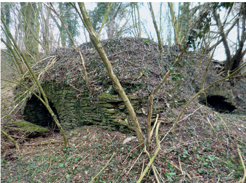
1 Ratingen-Hasselbeck. Ansicht des Kalkofens mit Arbeitsöffnungen von Süden.
