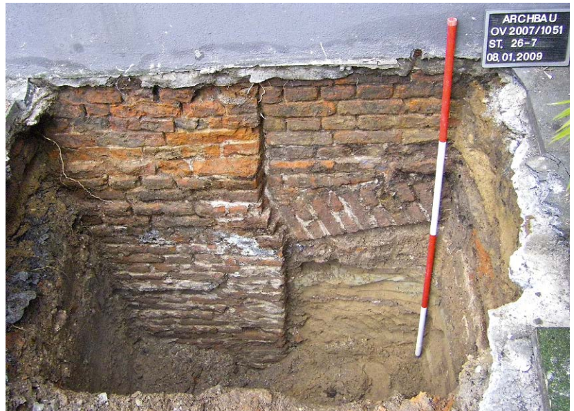
3 Düsseldorf-Altstadt. Entlastungsbogen des Nordflügels in Sondageschnitt 26.
