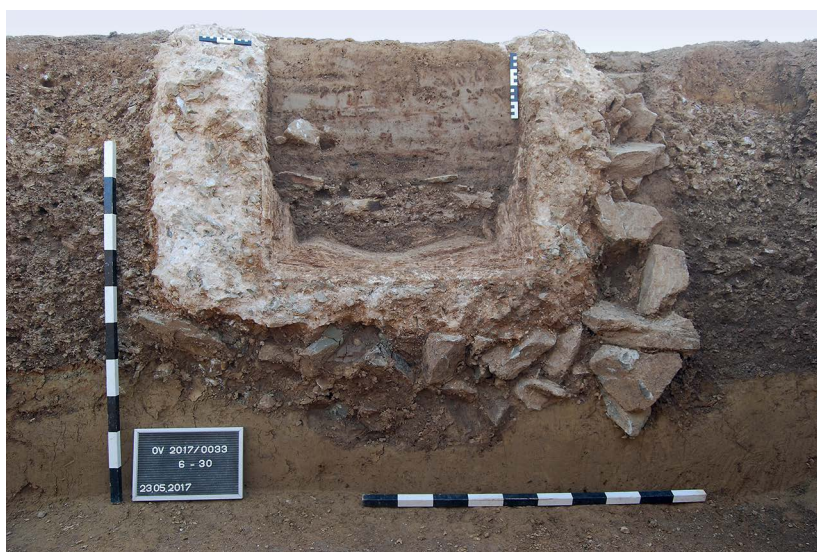
1 Rheinbach, Gewerbe- und Büropark Nord II. Querschnitt durch die erhaltenen Reste der römischen Wasserleitung.
