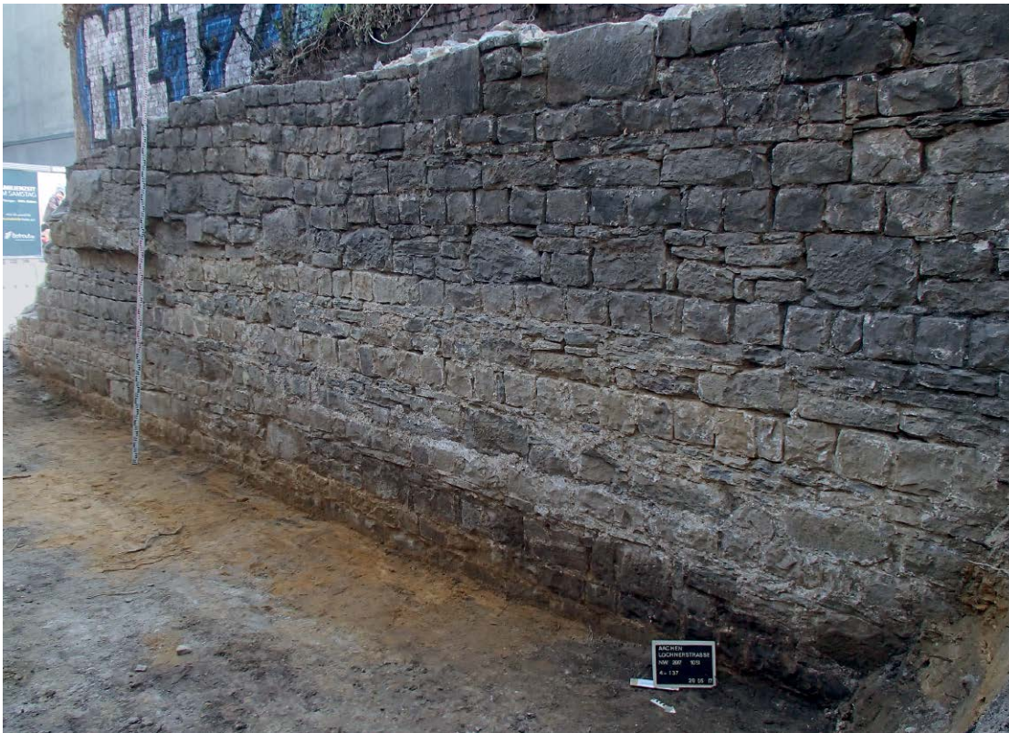
1 Aachen-Mitte, Lochnerstraße 48. Die jüngere Stadtmauer mit der Reparaturstelle (links).
