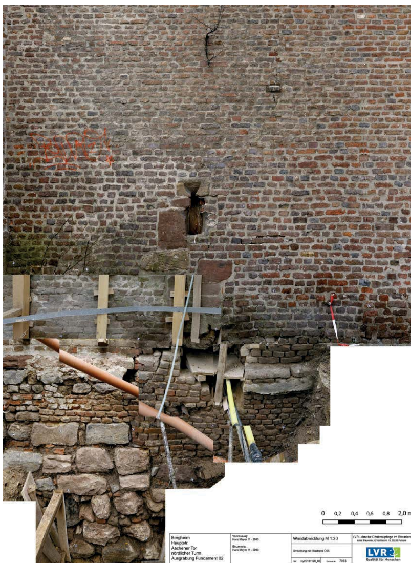
2 Bergheim. Teile des Nordturmfundaments des Aachener Tores in der fotogrammetrischen Aufnahme.
