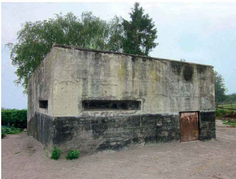
2 Velbert-Rottberg. Dreidimensionales Aufmaß des Leitbunkers, Darstellung von unten.
