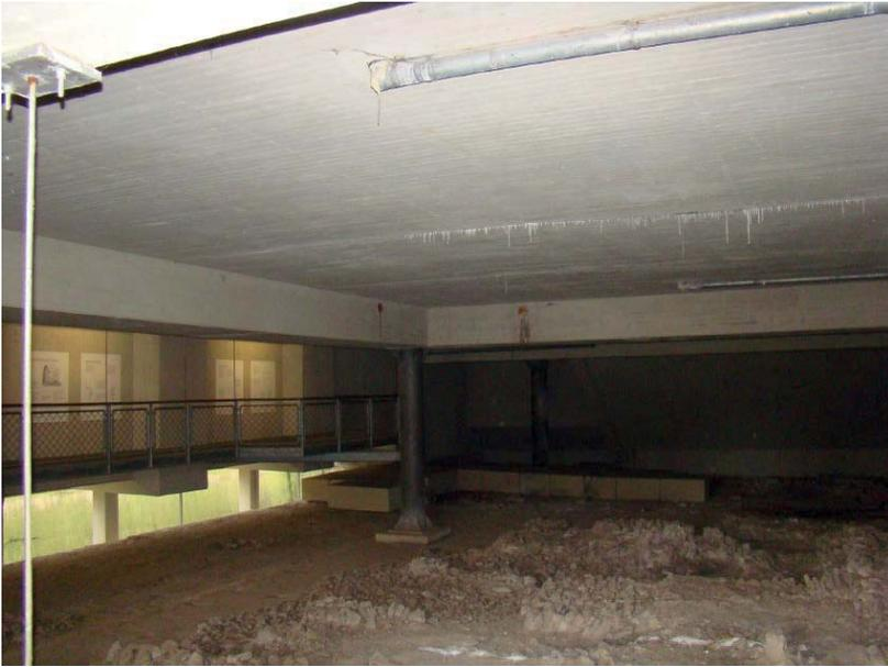
4 Xanten, CUT. Untergeschoss des Hafentempels mit Kalkablagerungen auf dem antiken Fundament.
