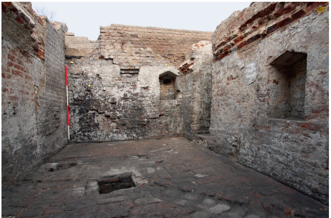
4 Duisburg, Universitätsstraße. Südlicher Keller des „Großen Ordenshauses“ mit Lichtnischen in der West- und Nord-mauer.
