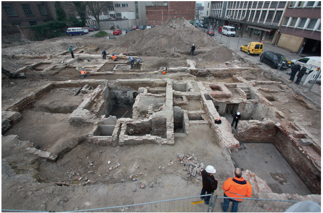
3 Duisburg, Universitätsstraße. Übersicht über das Grabungsgelände von Ost. Im Vordergrund spät-mittelalterliche Keller des „Großen Ordenshauses“.
